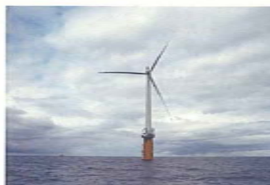
ノルウェー 設置時期: 2009年9月 発電機サイズ: 2.3MW
